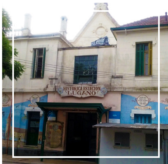
Foto 13: La Estación alrededor de 2017
